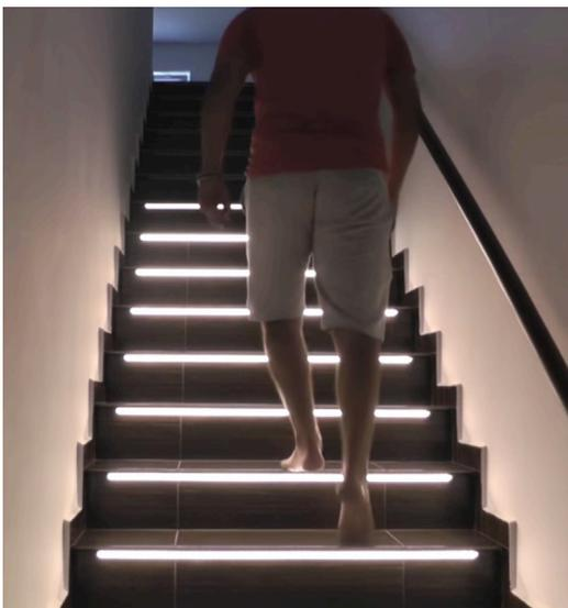
Los sensores de movimiento sirven para controlar de manera inteligente la iluminación de la escalera. Son de activación automática al dar un paso en el primer escalón (en cualquiera de los dos sentidos). El encendido y apagado de la iluminación LED se produce de una manera fluida al iniciar el ascenso o descenso.
